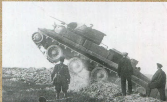
★ ПТ-1А на ходовых испытаниях.
